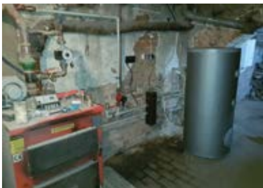
Przed modernizacją kotłowni
